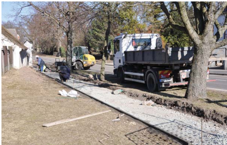
Dokončení rekonstrukce chodníku od obecního úřadu ke konci obce směrem ke hřbitovu
