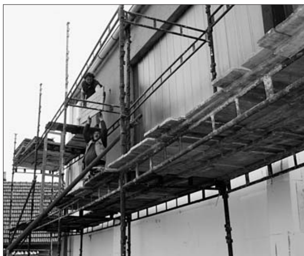
Vlkovská sokolovna má díky Nadaci ČEZ nové zateplení i fasádu.
